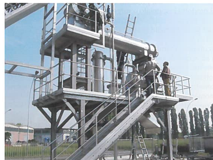
Fig. 7.15 - Impianto per pelatura termofisica a vapore (CFT SpA).
